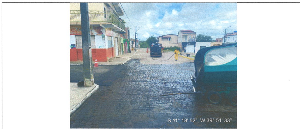
Foto 09 – RUA BEIRA RIO
