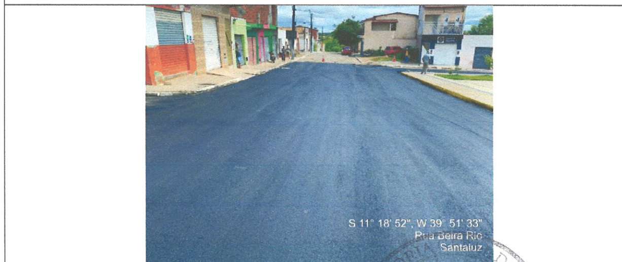
Foto 10 – RUA BEIRA RIO
